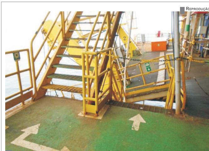
INSEGURANÇA - Deck deformado após acidente com baleeira em PNA-2
